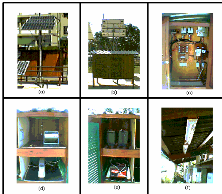
Figura 3.14. (a) Geradores FV/ vista frontal; (b) Abrigo / vista posterior; (c) Controladores de carga, sensores de corrente, interruptor horário, relés; (d) SAD e “no-break”; (e) Acumuladores; (f) Cargas / Lâmpadas fluorescentes.
